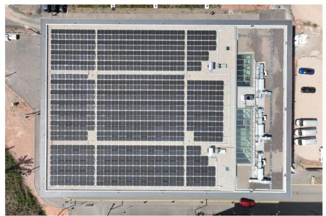
Die elektrische Leistung beträgt 280 kWp, der erwartete jährliche Stromertrag liegt bei etwa 300 MWh. Um den am Parkhaus erzeugten Solarstrom im MVZ, auf dem aufgrund des Denkmalschutzes keine PV-Anlagen installiert werden können, nutzen zu können, wurden die beiden Gebäude durch eine Kundenanlage nach §3 Nr. 24a EnWG verbunden (früher Arealnetz genannt).
