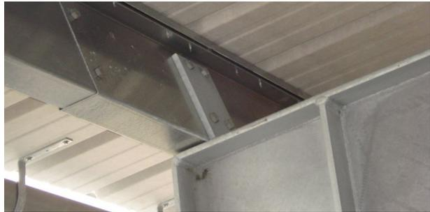
Bild 2. Z-Pfette mit Anbindung an das aufliegende Trapezblech und Befestigung an der Stahl-Auflagerplatte
