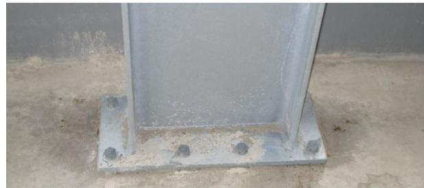
Bild 11. Auflagerdetail Fußpunkt Mittelstütze
