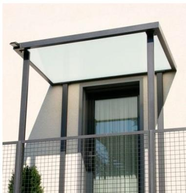
Bild 10. Beispiel einer Überkopfverglasung
