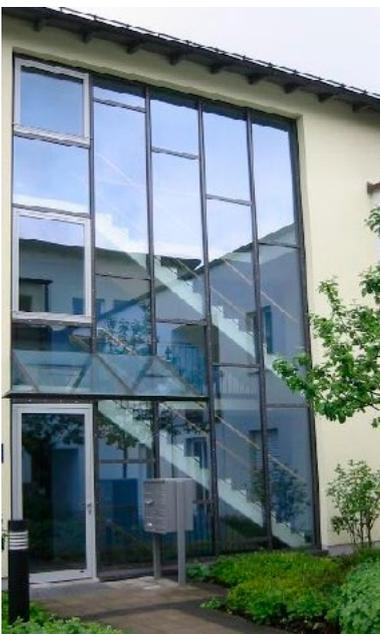
Bild 8. Beispiel einer Vertikalverglasung
