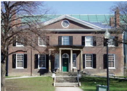
Bild 3. Südansicht Herrenhaus Grange im Jahr 2004
