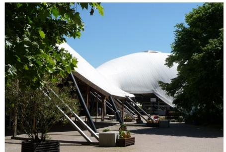
*Bild 7. Stahlseile an den Fußpunkten*
