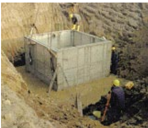
Bild 1: Abwasserpumpwerk
